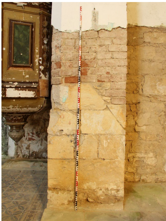
Čelní pohled na jižní líc severní stojky vítězného oblouku s cihelnou zadržkou a šikminou v ostění po starším nástupu na kazatelnu. Foto: Jaroslav Skopec, 2019.
