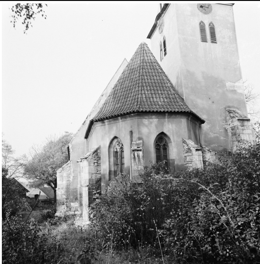
Kostel v pohledu od východu. Foto: 1987, sbírka negativů NPÚ ÚOP v Ústí n. L., sig. 96169.
