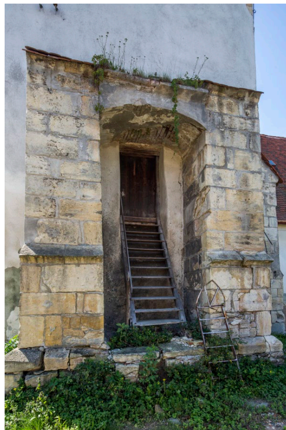
Severní vstup do 1. patra věže v pohledu od severu. Foto: Marta Pavlíková, 2019.
