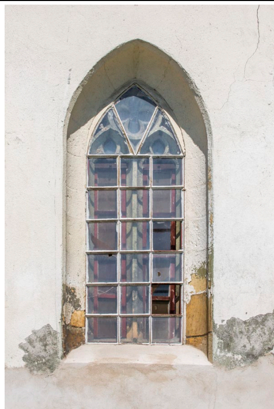
Jihovýchodní okenní otvor presbytáře v pohledu od jihovýchodu. Foto: Marta Pavlíková, 2019.
