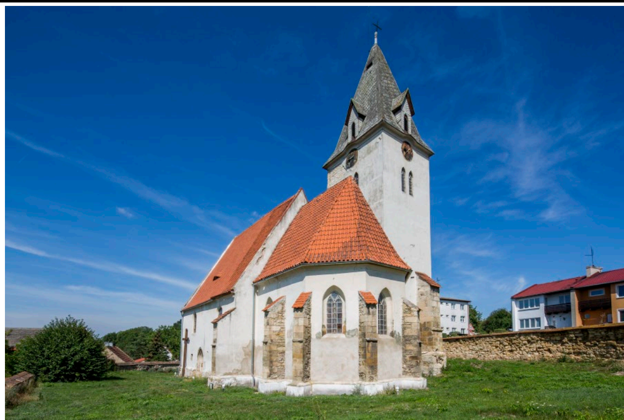
Celkový pohled od jihovýchodu. Foto: Marta Pavlíková, 2019.
