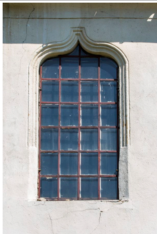
Jižní okenní otvor lodi s oslím hřbetem v záklenku v pohledu od jihu. Foto: Marta Pavlíková, 2019.
