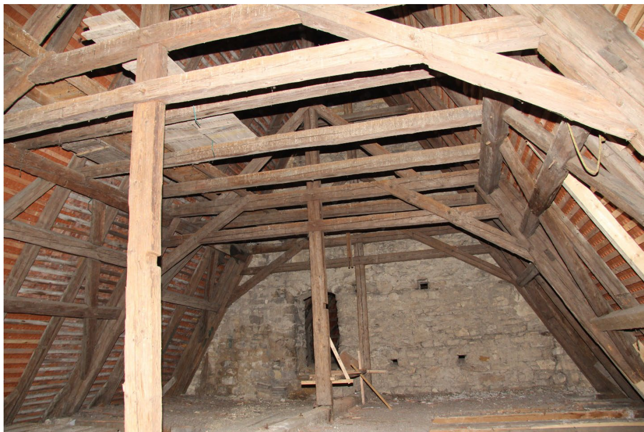
Krov nad lodí v pohledu od západu. Foto: Jaroslav Skopec, 2021.
