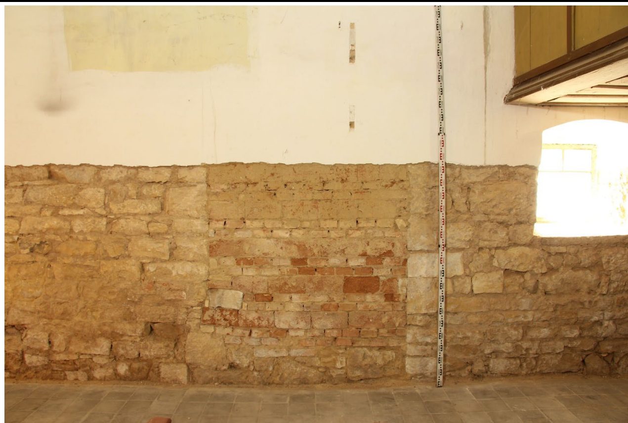
Detail zadržané niky středověkého jižního vstupu v pohledu od severu. Foto: Jaroslav Skopec, 2019.
