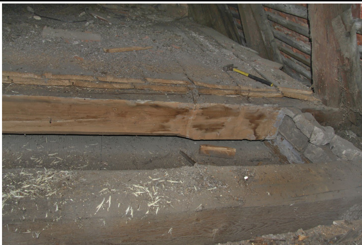
Zhlaví vazného trámu krovu nad lodí, které zároveň tvořily pohledový trámový strop. Foto: Jaroslav Skopec, 2021.
