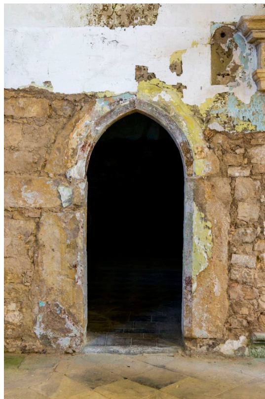
Čelní pohled na portál do sakristie. Foto: Marta Pavlíková, 2019.
