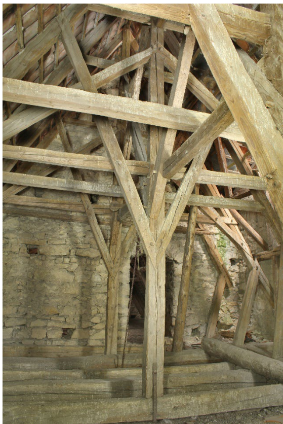
Krov nad presbytářem v pohledu od východu. Foto: Jaroslav Skopec, 2018.
