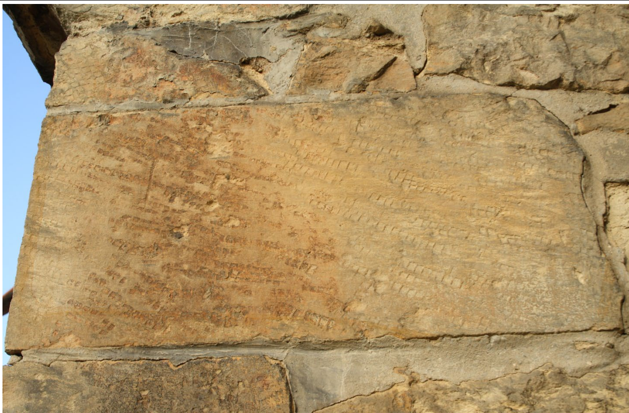
Detail stop po opracování plošinou s plochými zuby na kvádru jižního opěrného pilíře presbytáře. Foto: Jaroslav Skopec, 2015.
