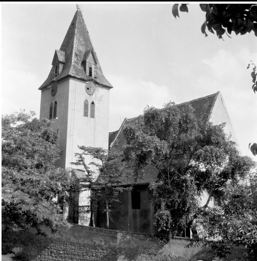
Kostel v pohledu od severozápadu. Foto: 1963, sbírka negativů NPÚ ÚOP v Ústí n. L., sig. 9228.
