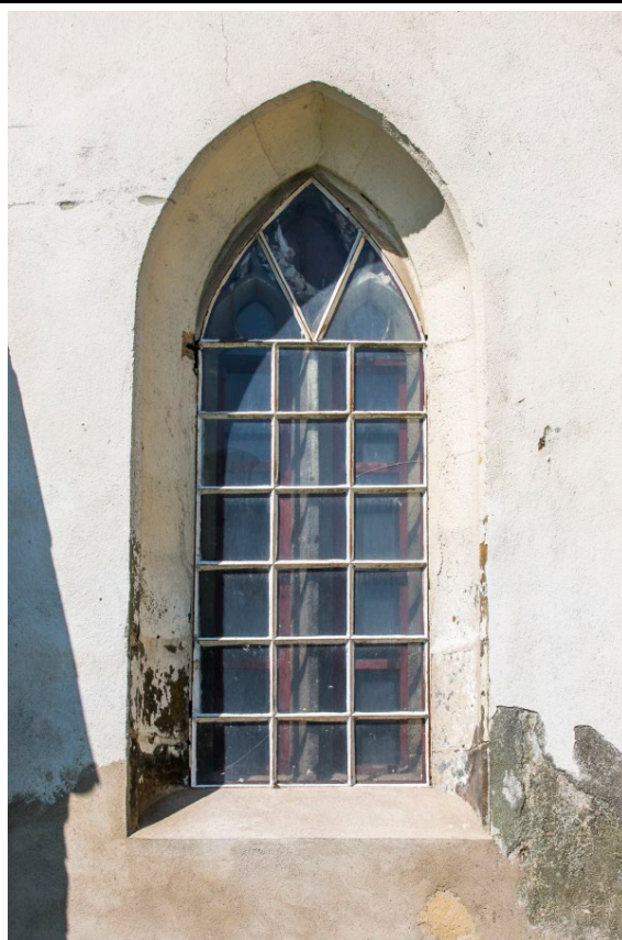
Východní okenní otvor presbytáře v pohledu od východu. Foto: Marta Pavlíková, 2019.
