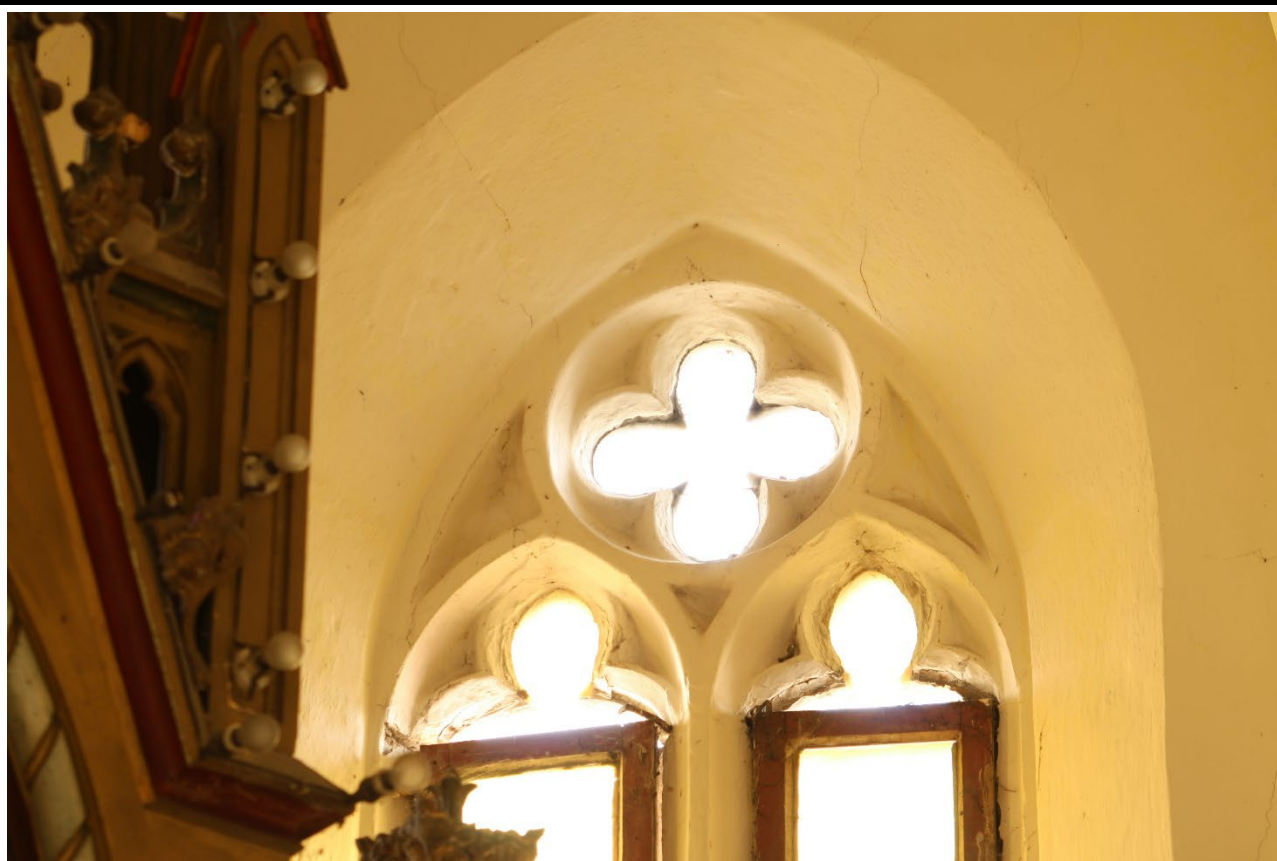
Detail kružby jihovýchodního okenního otvoru presbytáře. Foto: Marta Pavlíková, 2019.
