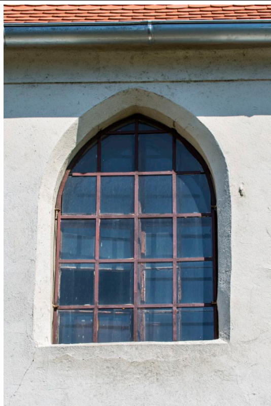
Jižní hrotitý okenní otvor lodi v pohledu od jihu. Foto: Marta Pavlíková, 2019.
