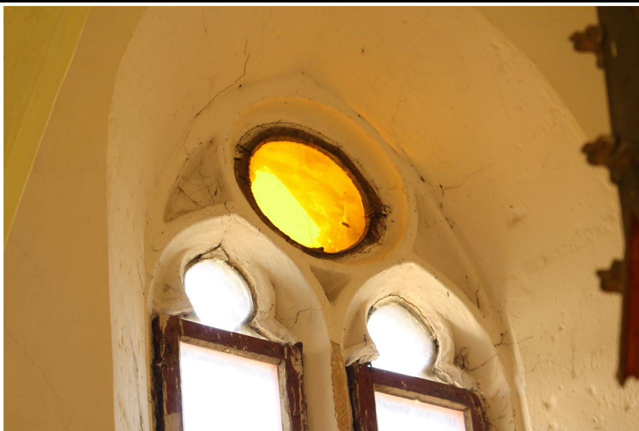
Detail kružby východního okenního otvoru presbytáře. Foto: Marta Pavlíková, 2019.
